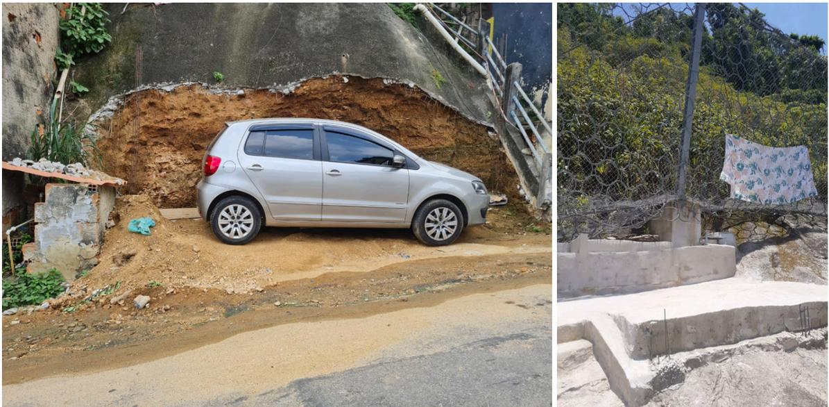
Na imagem da esquerda um morador recortou uma estrutura de contenção (concreto projetado) para ser utilizado como “vaga de garagem”. Na imagem da direita há uma barreira de contenção de blocos rochosos que o morador utilizou parte da estrutura no início da construção de uma moradia. Fonte: Fundação Geo-Rio, 2024.
