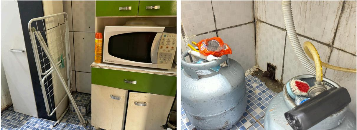
Ambas as imagens são de um imóvel em uma área da Cidade do Rio de Janeiro que recebeu intervenção estrutural (cortina atirantada) sob coordenação da Fundação Geo-Rio. O morador aproveitou a estrutura da obra de contenção como estrutura da própria moradia. Inclusive retirando uma das proteções da cabeça do tirante, o que pode comprometer a estabilidade da estrutura. Fonte: Fundação Geo-Rio, 2024.
