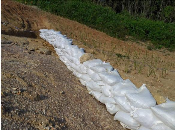
Almofadas ancoradas abaixo da rocha exposta – dissipadores de energia da água. Fonte: SMAC, 2024.
