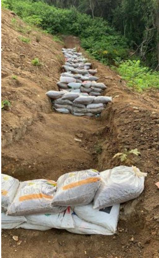
Almofadas ancoradas na vala de drenagem – dissipadores de energia da água. Fonte: SMAC, 2024.
