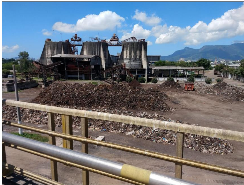
Fig. 10 - Ecoparque da Comlurb, no bairro do Caju.
