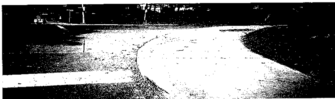
Figura 4 - Calçada em concreto simples com o relevo podotátil de alerta e rebaixamento arco para a travessia de pessoas com deficiência. Local: Bairro residencial na Cidade de Montreal – Canadá. Fonte: Acervo Eng o Deise Carvalho- PCRJ.
