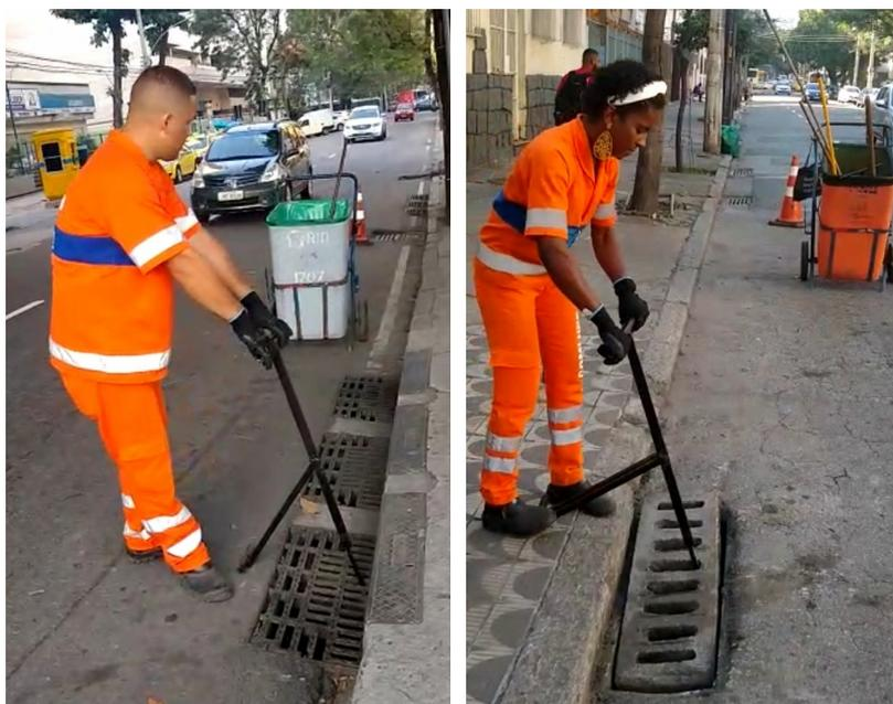
As premissas básicas do projeto focaram no peso do material empregado para sustentar a articulação da barra e, com isso, reduzir o desconforto do gari durante a operação.
