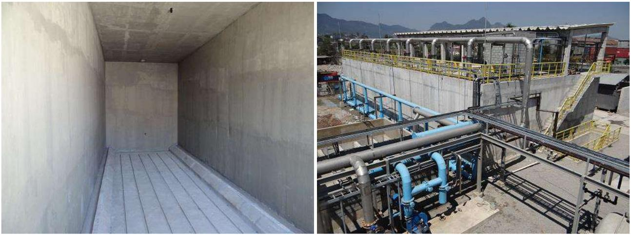
**Figura 9 – Vista do interior dos túneis, com detalhe dos canais de coleta de lixiviado (esq.) e vista superior do sistema de coleta de biogás e lixiviado da Unidade. Fonte: Methanum.**
