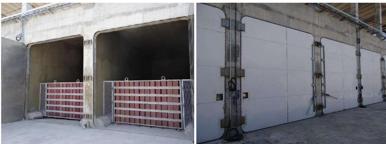
**Figura 8 – Vista frontal dos túneis abertos, com detalhe do sistema de suporte para os materiais, isolando-os da porta hermética (esq.) e vista dos túneis com as portas fechadas, durante o processo de tratamento anaeróbio. Fonte: Methanum.**
